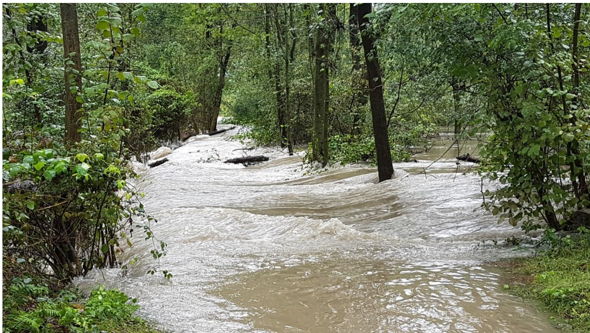
Diga della Pepa tra argine insommergibile e sommergibile (guardando verso Nord), fiume a 1'343 m 3 /sec a Bellinzona), 11.20 - 3.10.2020.
