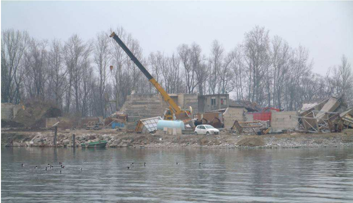
Silos Ferrari in smatellamento (febbraio 2007)
